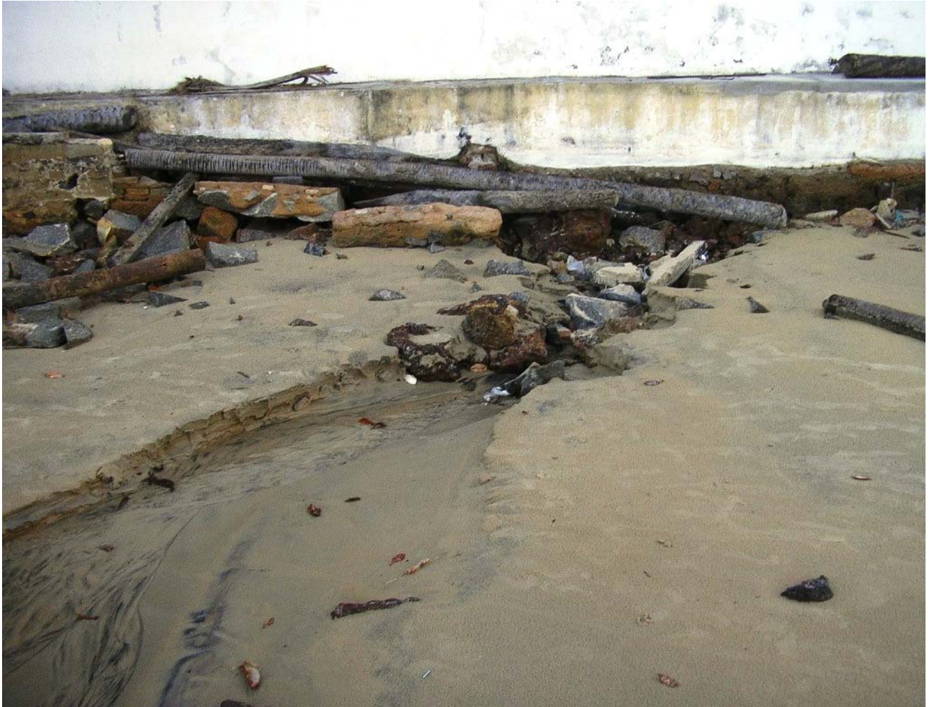
Figura 10: Ponto Extra 09 (água saindo por baixo da calçada do restaurante Marina Badauê, na praia de Pirangi do Norte).
