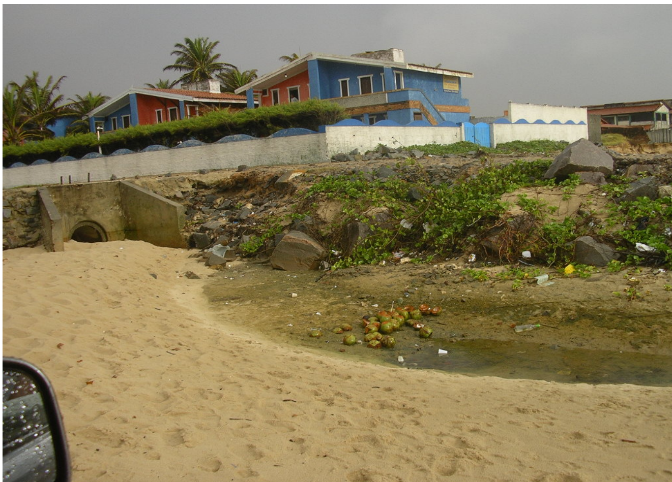
Figura 02: Ponto Extra 01 (saída de galeria pluvial, ao lado do Hotel Atlântico Norte, na praia de Redinha Nova).
