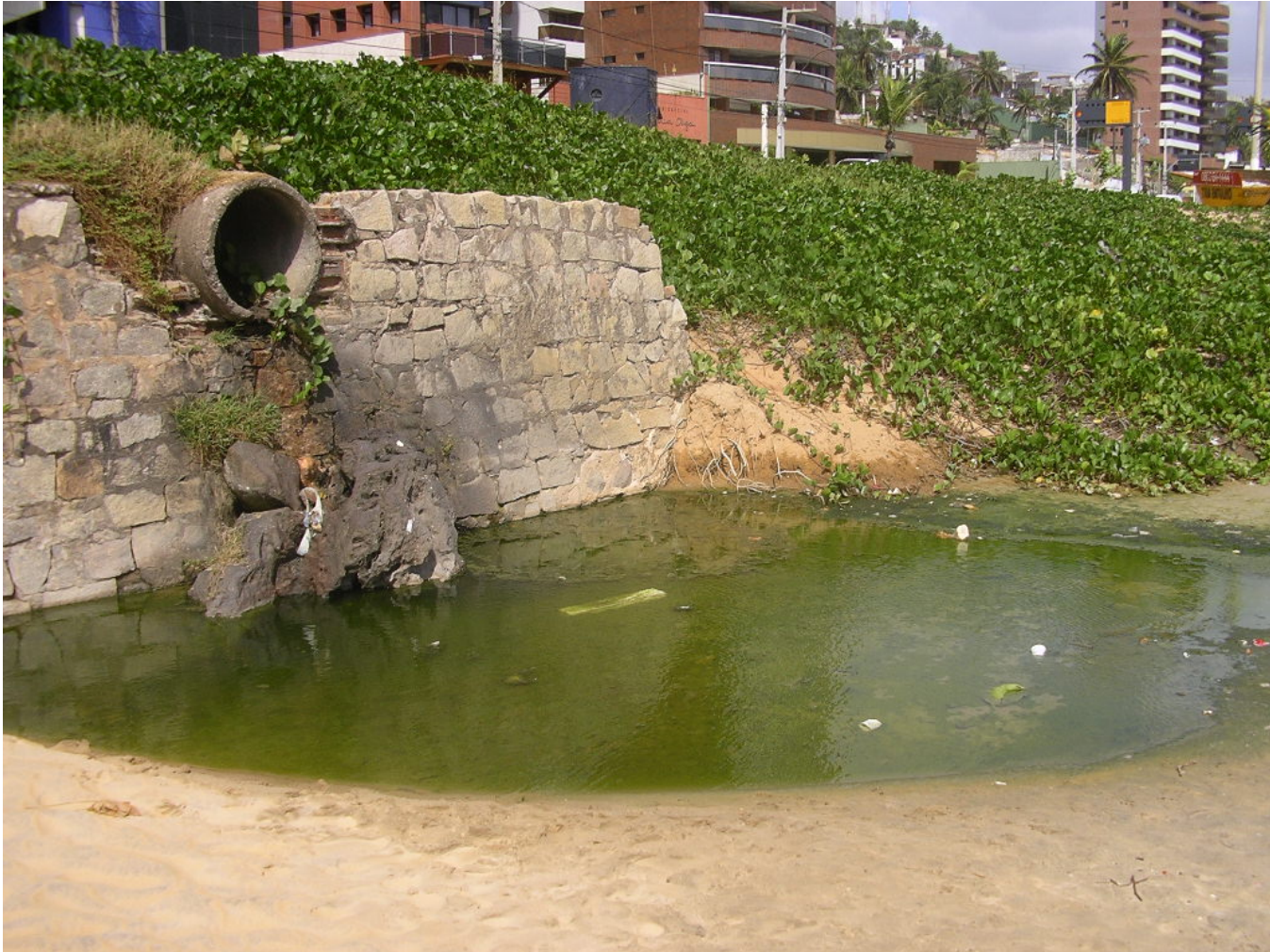
Figura 07: Ponto Extra 06 (saída de galeria pluvial ao lado do “Relógio Solar”, na praia de Miami).
