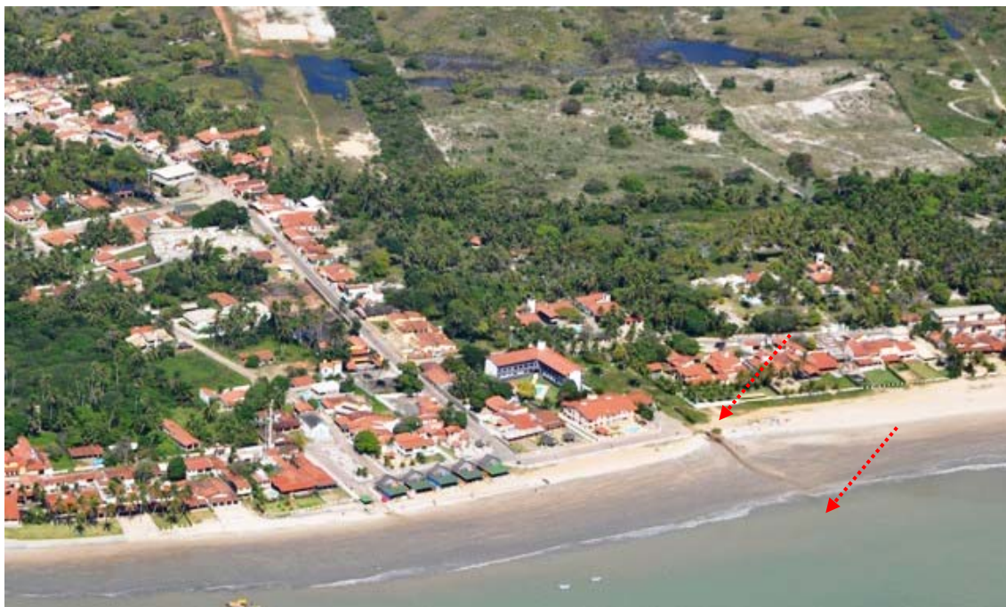
Figura 1 – Fotografia mostrando o núcleo urbano / praia de Muriú, no município de Ceará-Mirim – RN, com indicação dos locais vistoriados (indicados pelas setas em vermelho).
