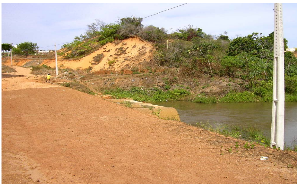
Figura 30. Estação PI-11, localizada em uma área bastante degradada, apresentado avançado processo de assoreamento.
