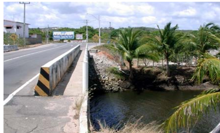
Figura 3 - Estação de monitoramento PI-02 (ponte nova sobre o rio Pium/Pirangi, em Pirangi do Norte).
