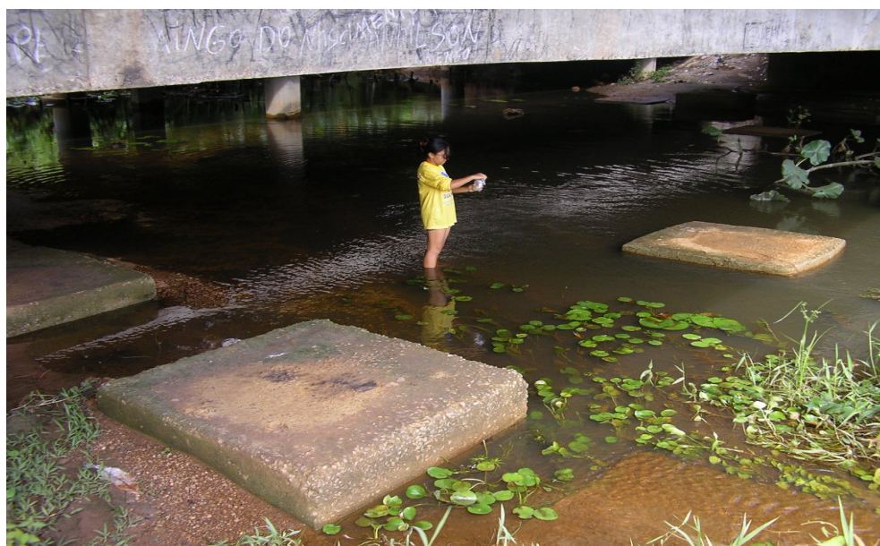
Figura 32. Estação de monitoramento PI-13, localizada sob o vão de uma ponte na BR-304.
