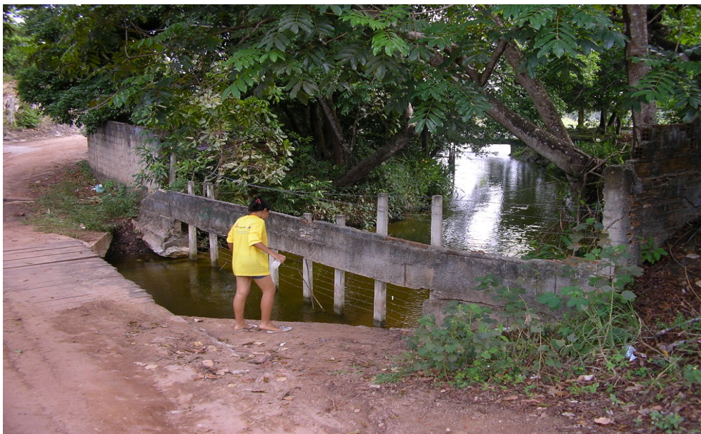
Figura 26. Estação de monitoramento PI-07, localizada à jusante do balneário “lago azul”.
