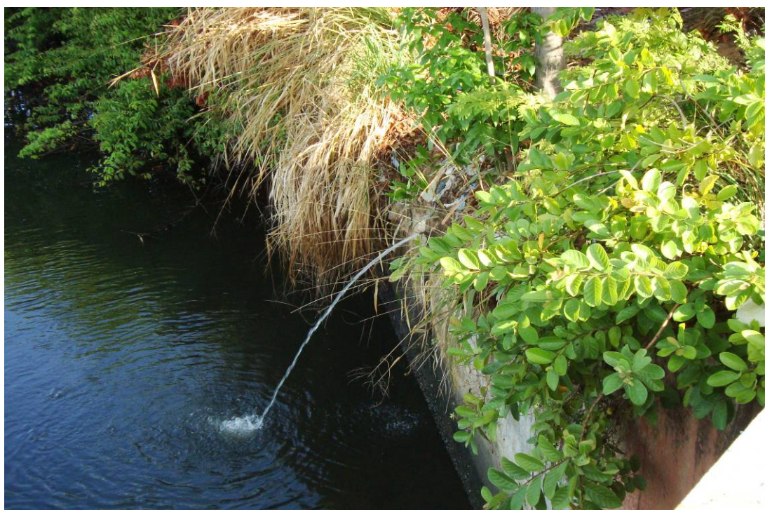
Figura 21 – Fotografia mostrando o lançamento de esgoto doméstico, posicionado poucos metros à montante do ponto de coleta da PI-01.
