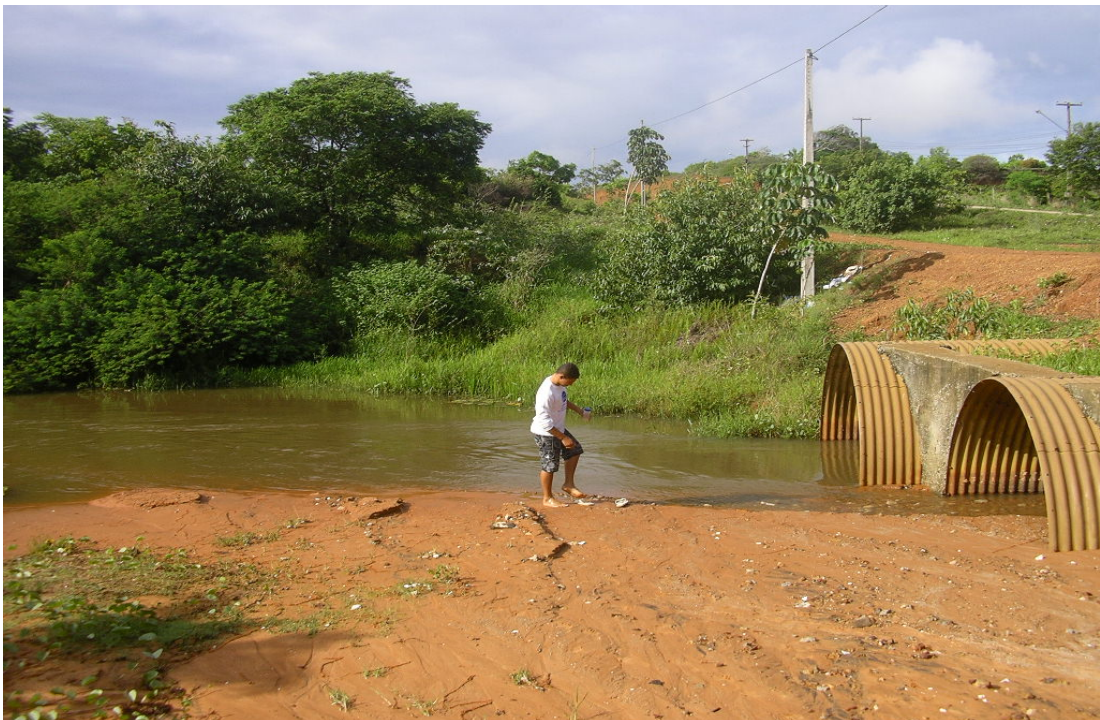
Figura 33 – Fotografia mostrando, em detalhe, o severo assoreamento do leito do Rio Pitimbu, junto à estação de monitoramento P-11.
