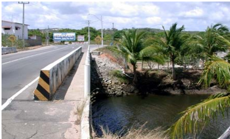
Figura 3 - Estação de monitoramento PI-02 (ponte nova sobre o rio Pirangi, em Pirangi do Norte).
