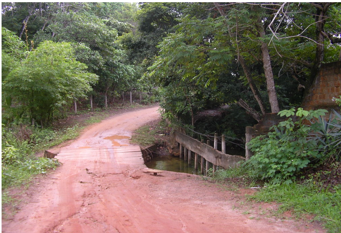
Figura 28 – Fotografia mostrando a estação de monitoramento PI-07, considerada a de melhor condição de balneabilidade, conforme resultados do monitoramento executado em janeiro/2011.
