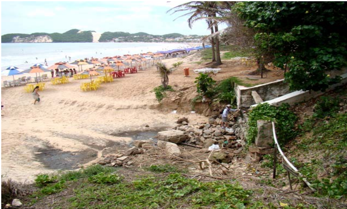
Figura 8 – Fotografia mostrando ponto de lançamento de efluentes na Praia de Ponta Negra (NT 04 - galeria pluvial posicionada junto ao calçadão).
