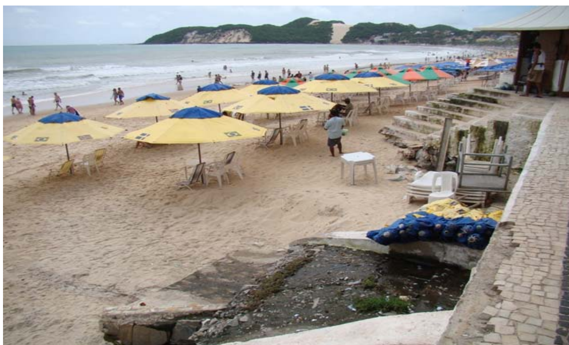
Figura 7 – Fotografia mostrando ponto de lançamento de efluentes na Praia de Ponta Negra (NT 03 - galeria pluvial posicionada junto ao calçadão, nas proximidades de Posto Salva-vidas do Corpo de Bombeiros), mesmo não havendo registro de chuvas recentes.
