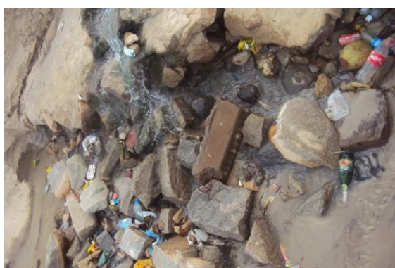
Figuras 08 e 09 – Praia do Forte - galeria de águas pluviais: embora sem registro de chuva, “água” saindo fétida e com resíduos sólidos.
