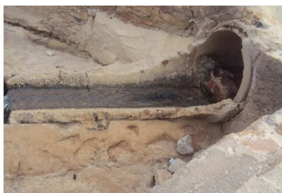
Figuras 08 e 09 – Praia do Forte - galeria de águas pluviais: embora sem registro de chuva, “água” saindo fétida e com resíduos sólidos.
