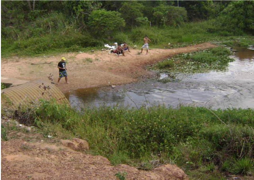
Figura 32. Estação PI-11, localizada em uma área bastante degradada, apresentando seu leito comprometido por avançado processo de assoreamento.
