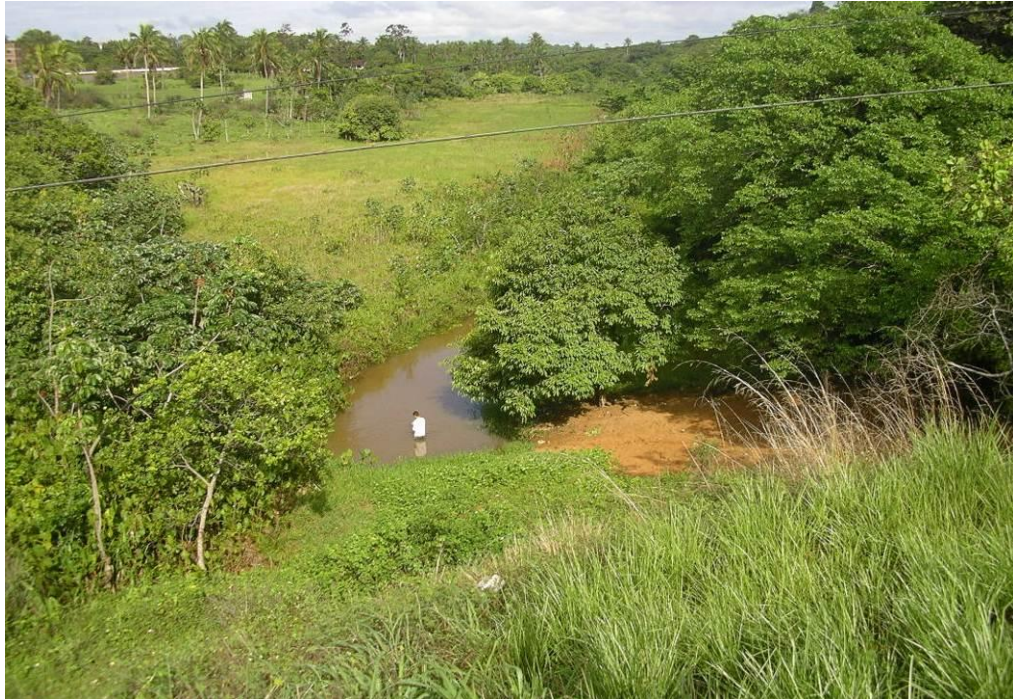
Figura 33. Estação PI-12, antes do início das obras para construção da galeria para escoamento das águas do rio Pitimbu (ano 2011).
