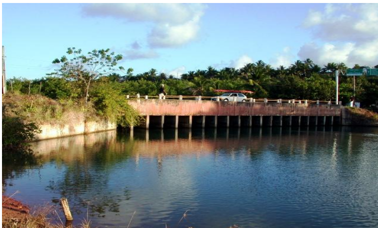
Figura 2 - Estação de monitoramento PI-01 (Ponte velha sobre o rio Pium/Pirangi, entre Pirangi do Norte e Pirangi do Sul).
