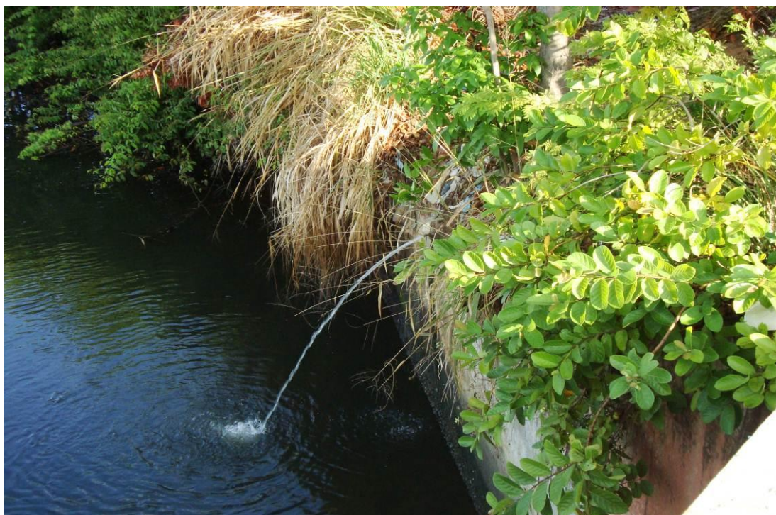
Figura 21. Registro do lançamento de esgoto doméstico situado poucos metros a montante da estação de coleta PI-01.
