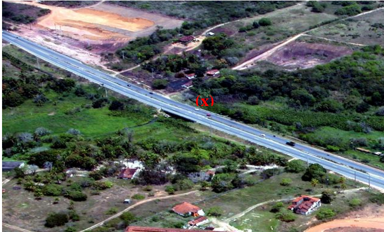
Figura 14 - Estação de monitoramento PI-13 (rio Pitimbu – rodovia BR-304).
