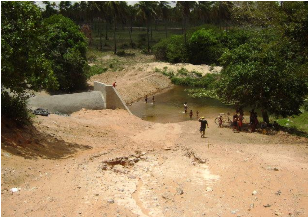
Figura 34. Estação PI-12, após o início das obras para construção da galeria para escoamento das águas do rio Pitimbu (ano 2012).
