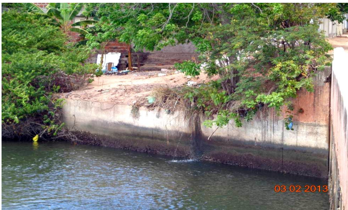
Figura 21. Fotografia registrando o lançamento de esgoto doméstico situado poucos metros a montante do ponto de coleta da PI-01.
