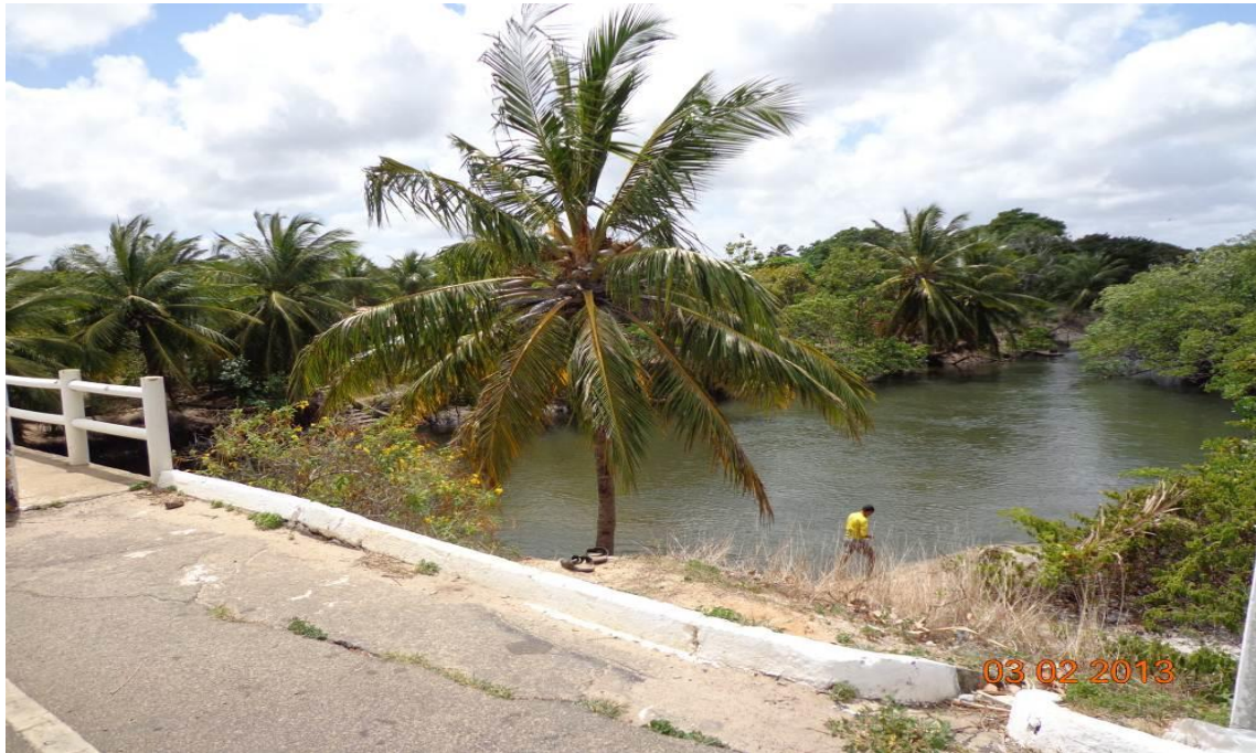
Figura 22. Estação de monitoramento PI-02, localizada ao lado da ponte nova de Pirangi do Norte.
