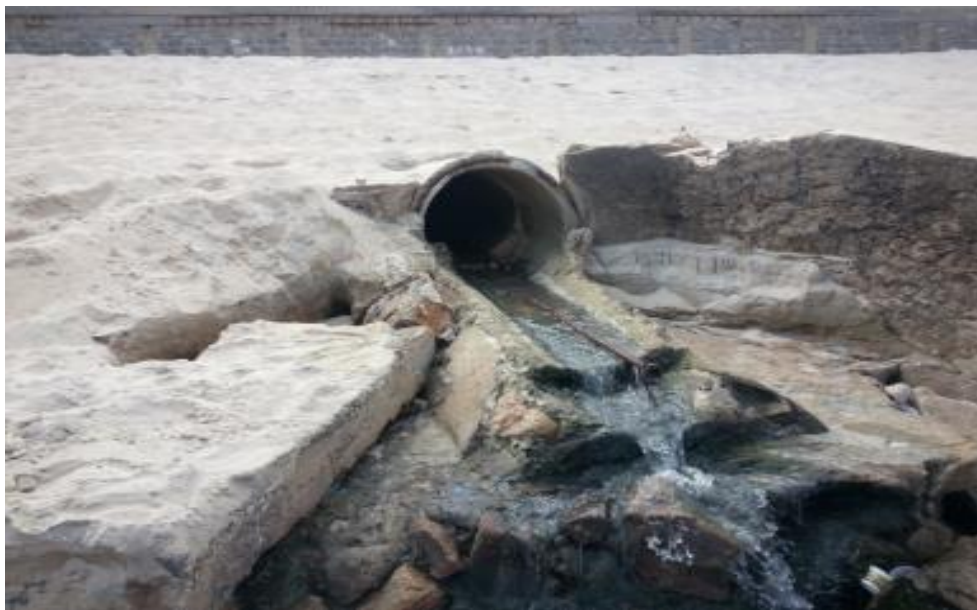
Figura 21 – Fotografia registrando o lançamento de esgoto in natura não tratados na Praia do Forte.
