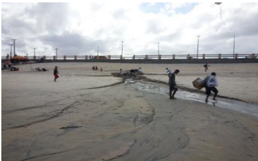
Figura 22 – Fotografia registrando o lançamento de esgoto in natura não tratados na Praia do Forte.
