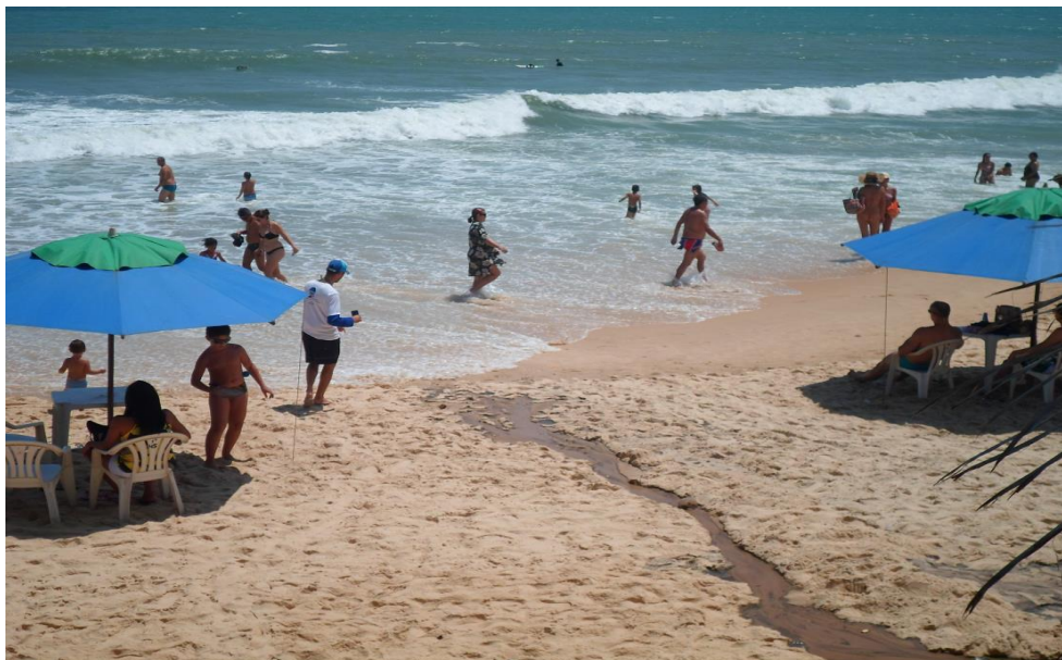
Figura 25 – Fotografia registrando poço de visita da CAERN jorrando esgoto na praia de Ponta Negra.
