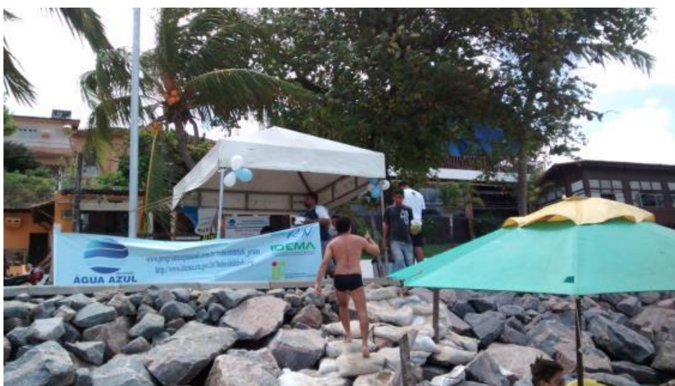
Figura 15 - Enrocamento instalado na praia de Ponta Negra visando proteger a linha de costa da erosão costeira.
