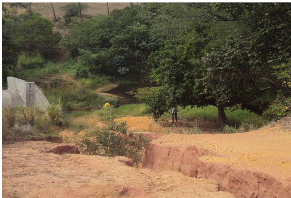
Figura 32. Fotografia mostrando aspectos gerais da estação de monitoramento PI-12, observando-se expressiva voçoroca originada por erosão pluvial.
