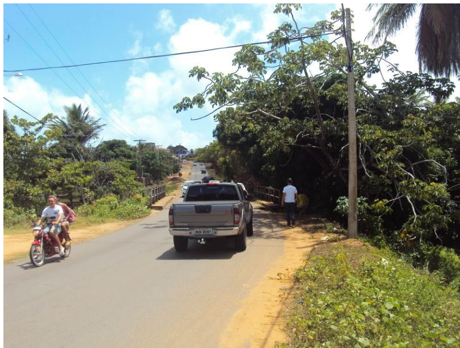
Figura 25. Fotografia mostrando a ponte sobre o rio Pium (rodovia RN-313), sob a qual se encontra a estação de monitoramento PI-06.
