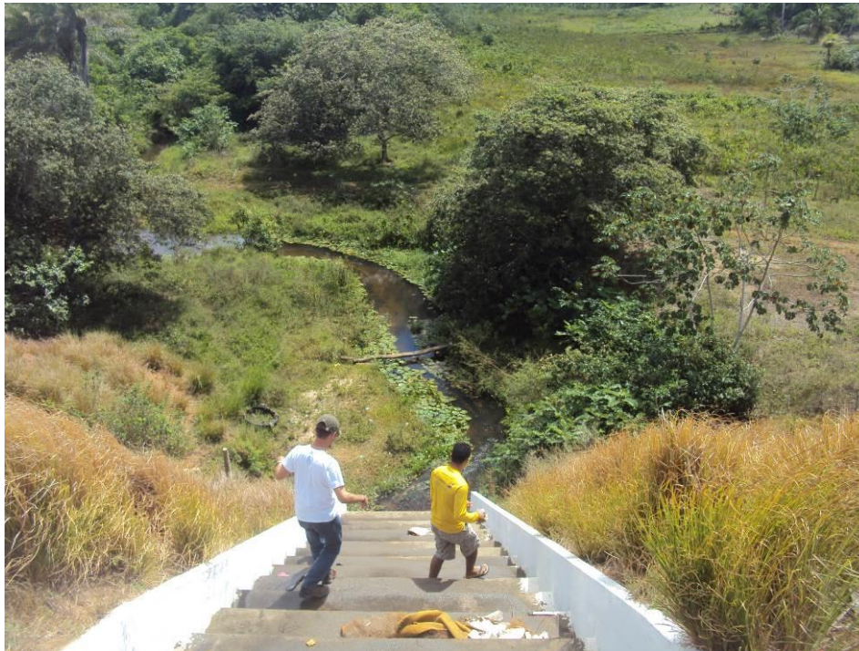
Figura 35. Aspectos gerais da estação de monitoramento PI-15, localizada no limite entre os municípios de Parnamirim e São José de Mipibu.
