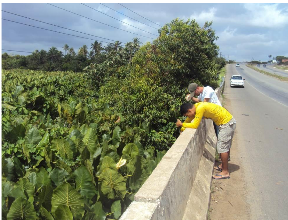
Figura 33. Aspecto geral da estação de monitoramento PI-13, localizada no rio Pitimbu, sob ponte na rodovia BR-304.
