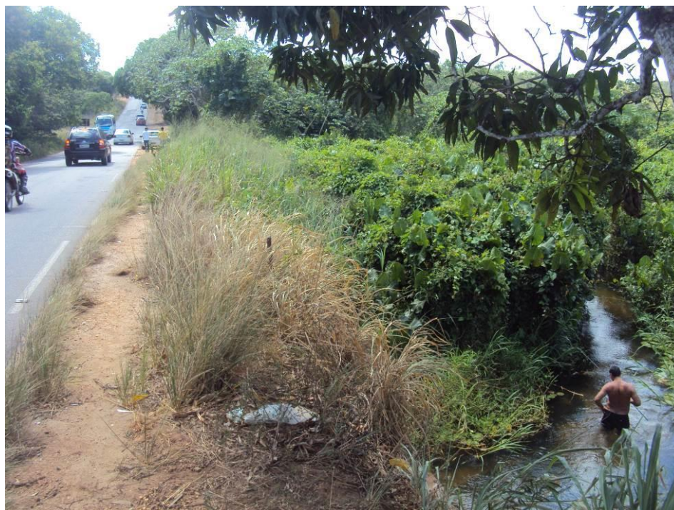
Figura 29. Aspectos gerais da estação de monitoramento PI-09, localizada no Riacho Taborda, junto à rodovia RN-313.
