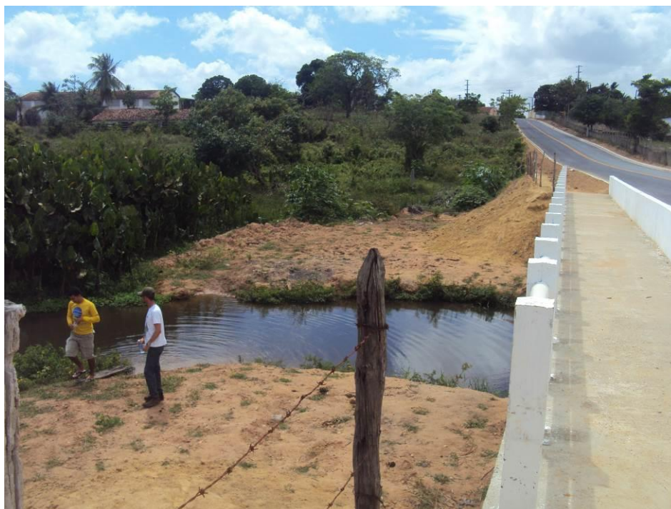
Figura 34. Aspectos gerais da estação de monitoramento PI-14.
