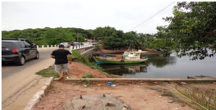
Figura 2. Estação de monitoramento PI-01 (Ponte velha), localizada na foz do rio Pirangi, entre as praias de Pirangi do Norte e Pirangi do Sul.
