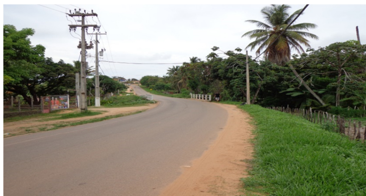
Figura 7. Estação de monitoramento PI-06, localizada sob uma ponte na rodovia RN-313, que passa sobre o rio Pium.
