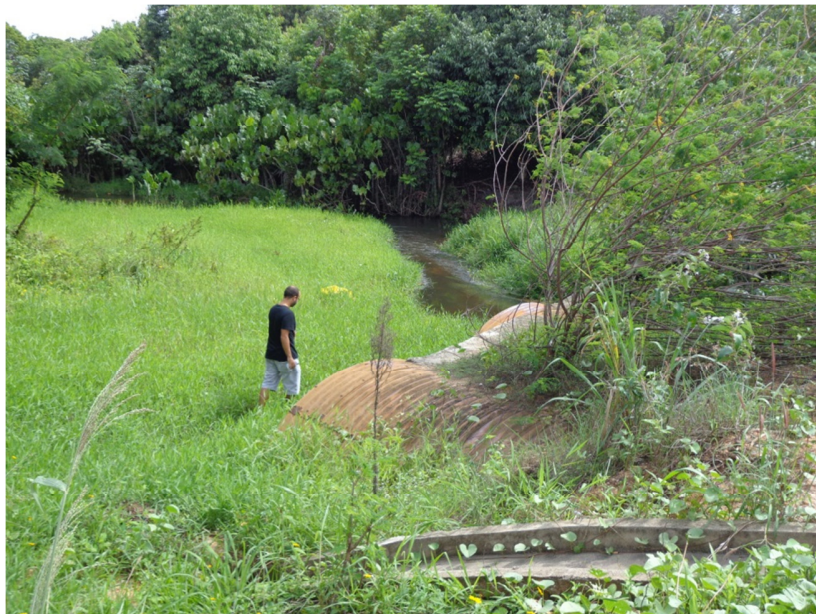
Figura 31. Estação PI-11, o último ponto de monitoramento no rio Pitimbu, antes de sua chegada à Lagoa do Jiqui.
