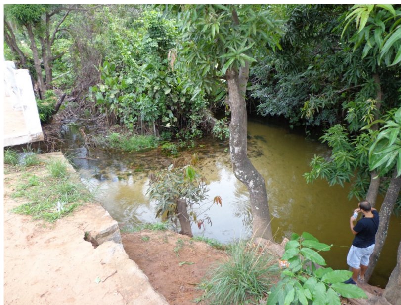
Figura 25. Detalhe da ponte sobre o rio Pium (rodovia RN-313), sob a qual se localiza a estação de monitoramento PI-06.
