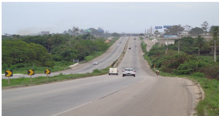
Figura 14. Estação de monitoramento PI-13, localizada no rio Pitimbu, sob a rodovia BR-304.
