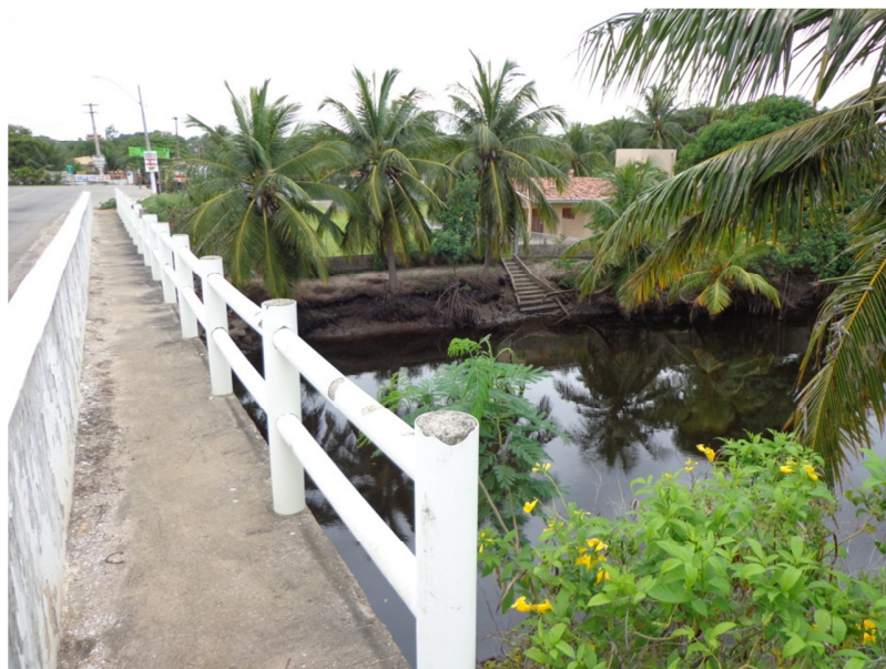
Figura 20. Estação de monitoramento PI-02, localizada sob a ponte nova de Pirangi do Norte, próxima ao “maior cajueiro do mundo”.
