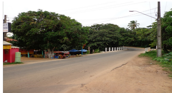
Figura 5. Estação de monitoramento PI-04 (Balneário do Pium), localizado na área de confluência dos rios Pitimbu e Pium.
