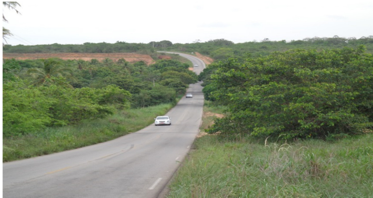
Figura 10. Estação de monitoramento PI-09, localizada no riacho Taborda, sob a rodovia RN-313.
