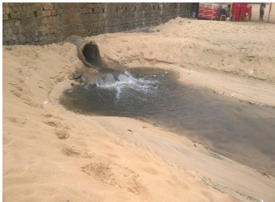
Figura 20 - Registro do lançamento de águas pluviais poluídas nas praias de Pirangi e do Meio.
